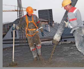
Concreto vertido en sitio
